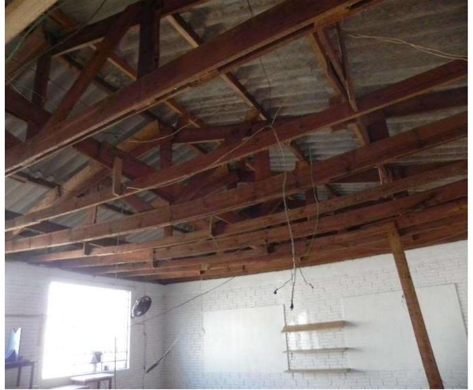
**Fotos während der Arbeiten (Ersatz der Deckenkonstruktion durch PVC Platten)**
